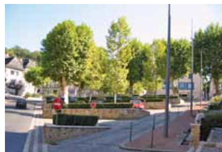
Gestion de la pente, maintien de la végétation à Terrasson Lavilledieu (24)
