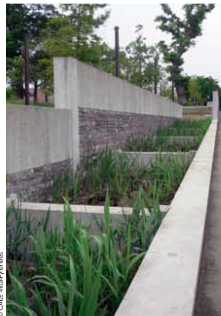
Aménagement pluvial en milieu urbain qui s'adapte à la topographie du lieu - Saint-Jacques de la Lande (35)
