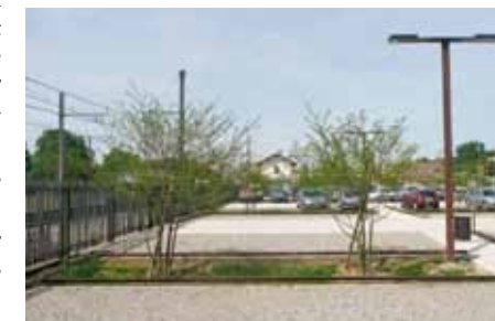
Réutilisation de matériaux (rails) pour le mobilier (bordures, clôtures, mâts). Parking gare Grisolles (82)
