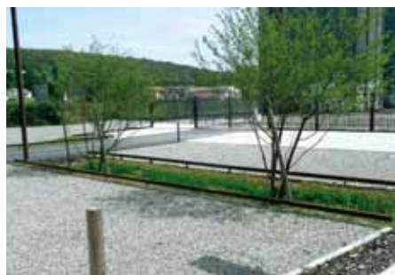
Revêtement perméable en nidagravel – Parking gare de Grisolles (82)
