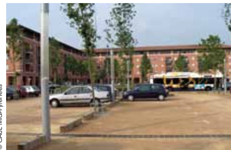
Parking en revêtement stabilisé à Borderouge Toulouse (31)
