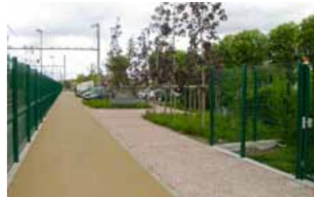
Piste cyclable d'accès à la gare de Muret (31)
