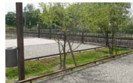
Noue de guidage et de rétention, avec possibilité de récupération pour arrosage Parking gare de Grisolles (82)
