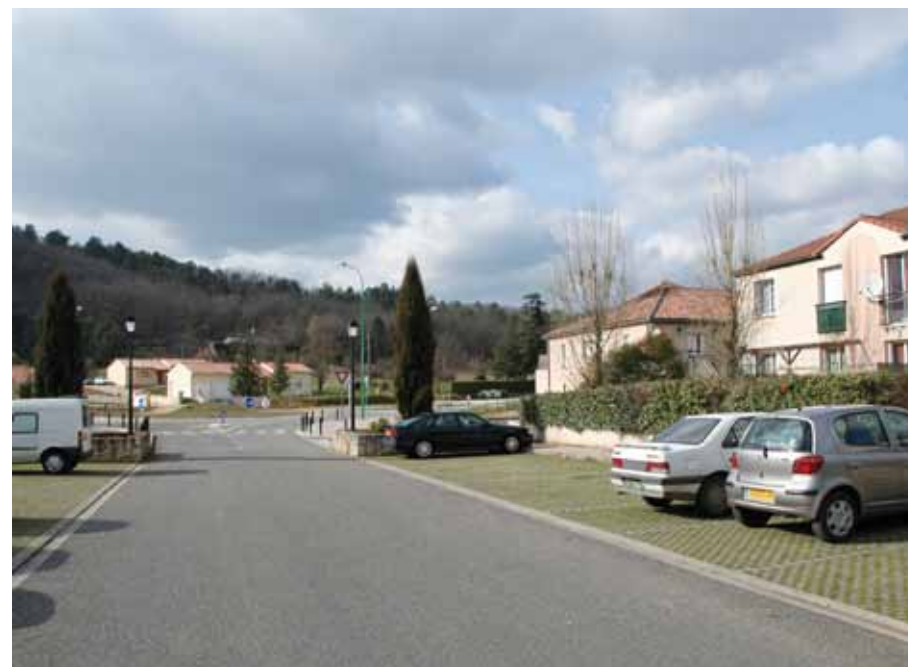
Sol perméable enherbé – Zone de stationnement dalle de béton ajouré – Pradines (46)
