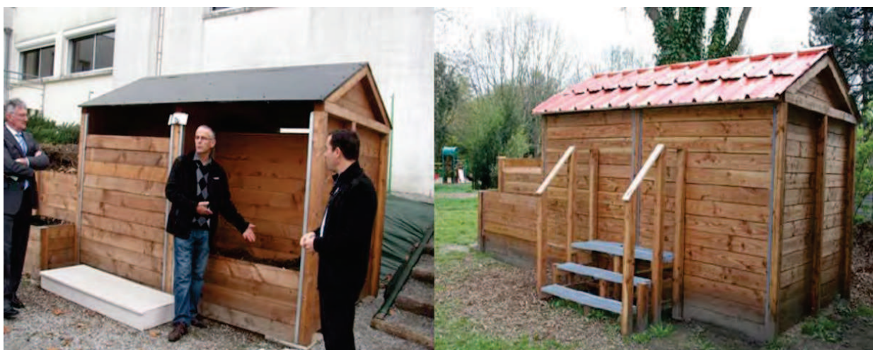
Pavillon de compostage 10m 3 (à gauche) et 20m 3 (à gauche)
